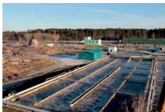
Липецкая станция аэрации
